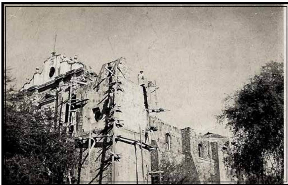
Fuente: fotografía 53. Víctor Manuel Arias Castillo, fotografía de su archivo y cortesía. Fotografía a quien corresponda el crédito. Reforzamiento estructural para solventar el cuerpo de la estructura sur que serviría para el agregado de la torre de campanario que hoy en día ostenta la iglesia. Técnica analógica.
