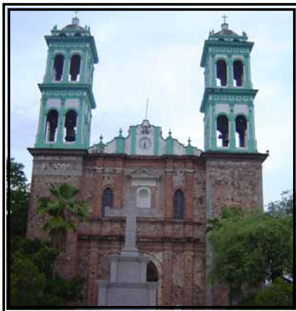
Fuente: Víctor Manuel Arias Castillo. Fotografía 48, de su autoría y cortesía. Estado actual de la que fuera iglesia de doctrina de San Juan Bautista Pungárihuato, hoy sede episcopal parroquia del Obispado de Cd. Altamirano, Gro. Penosamente, también se observa la incuria cometida en lo que fuera su cruz atrial o de mayo como los habitantes del pueblo la llaman, que a simple vista, aun con su construcción de cantera, resulta discordante con su hechura primitiva. Técnica digital. Archivo del autor.
