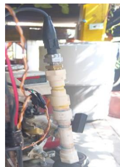
Fig. 11. Instalación del transductor de presión.
